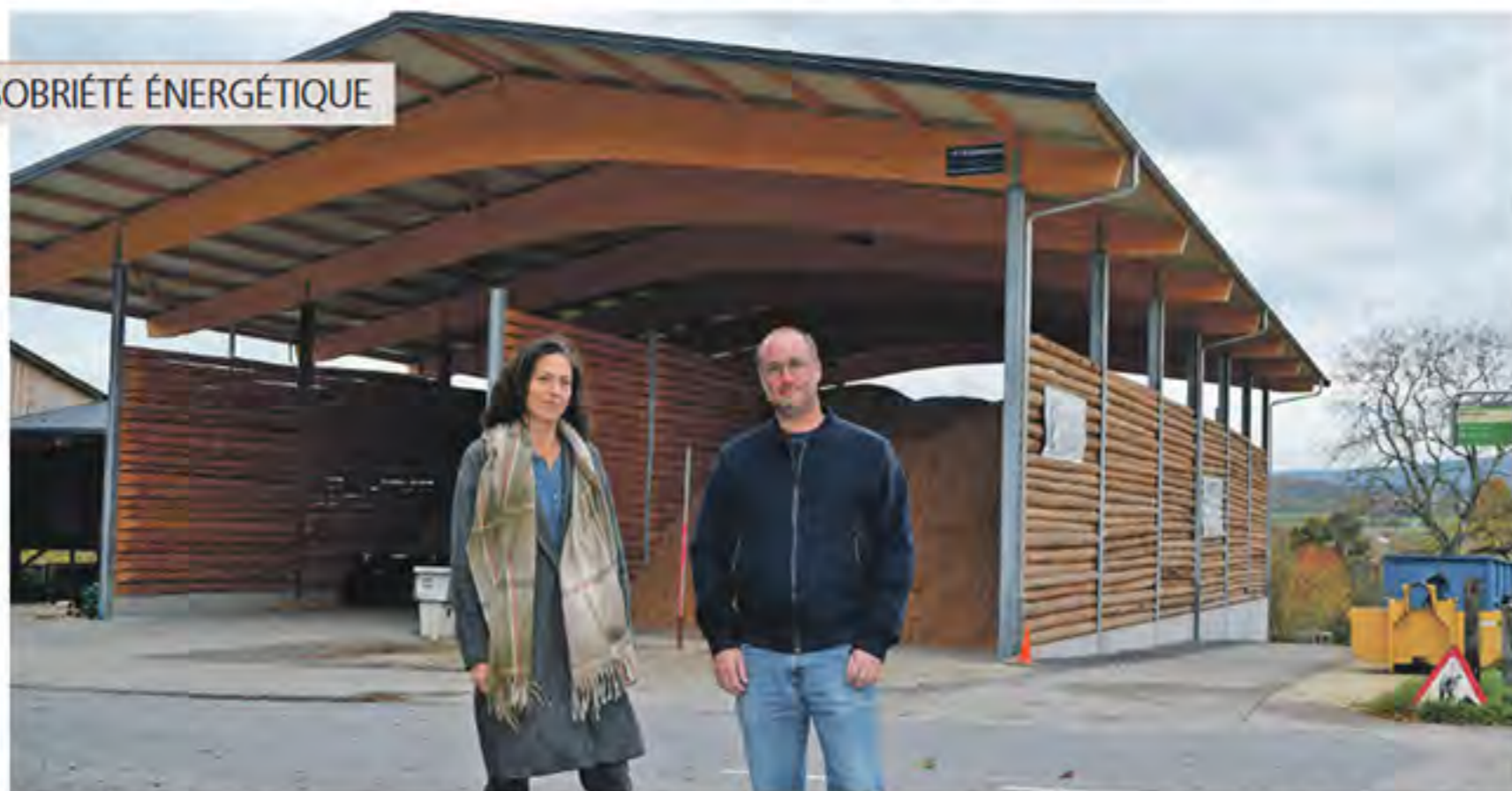
Karine Roch et Yves Schopfer, devant le hangar dont une partie du toit sera couverte de 500 m 2 de panneaux solaires. Phillippoz
